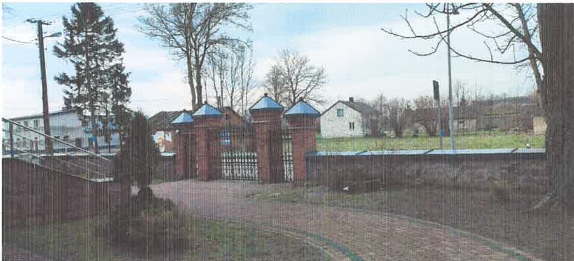
Zdjęcie 1 Widok bramy głównej od wewnętrznej strony
