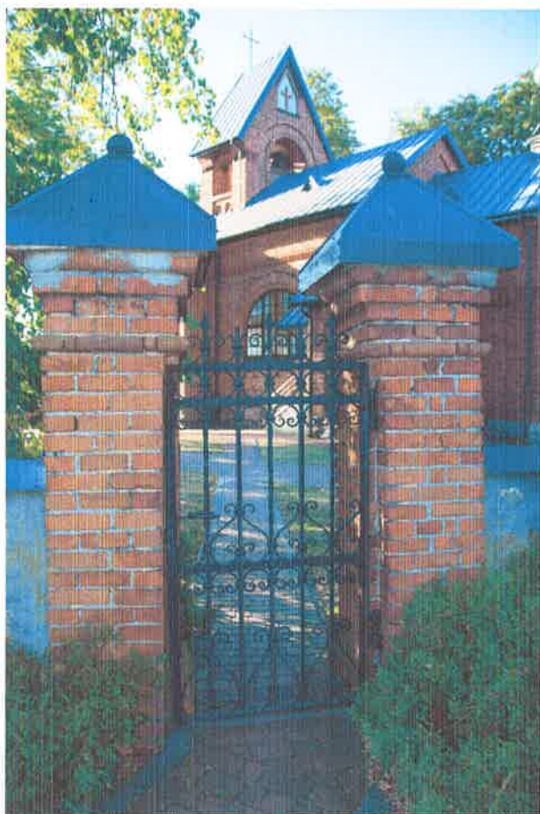
Zdjęcie 2 Widok furki bocznej od zewnątrz
